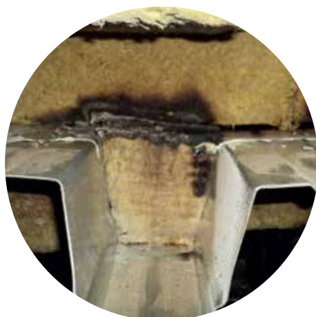
Специальные элементы из каменной ваты ROCKWOOL для заполнения гофр профнастила в соответствии СП 17.1330.2011 (кровли)
