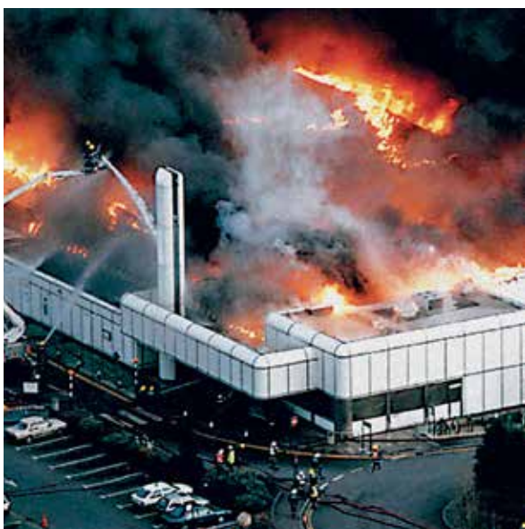
Пожар на кровле в аэропорту Дюссельдорфа (Германия)
