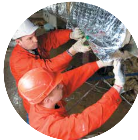
Монтаж негорючей теплоизоляции для конструкции воздуховода
