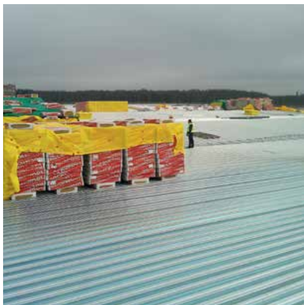
Монтаж пожаробезопасной кровли с негорючим утеплителем ROCKWOOL
