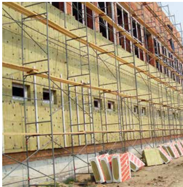
Монтаж вентилируемого фасада на объекте ФОН в г. Верхняя Синячиха (Свердловская область)
